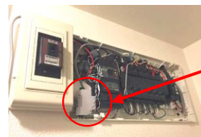
電力センサー設置例（分電盤に設置）
